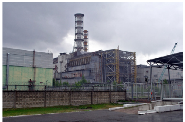
Foto 1. Estructura de hormigón denominada “sarcófago”, diseñada para contener el material radiactivo del núcleo del reactor, para una duración de 30 años. (Paweł ‘pbnm’ Szubert).
